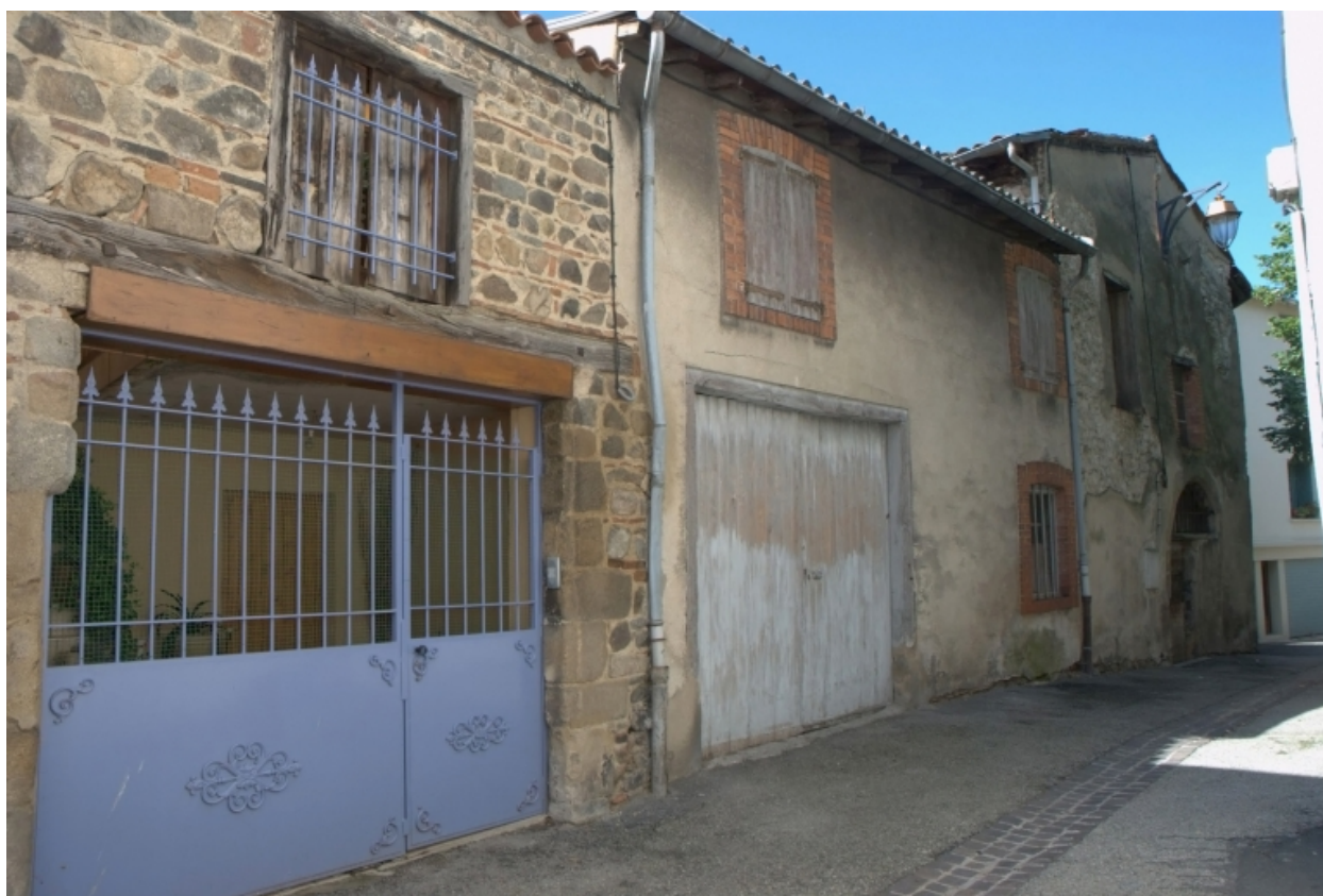
Îlot 3. Martyrs de Vingré (rue des) 03. Vue générale des façades sur rue.
