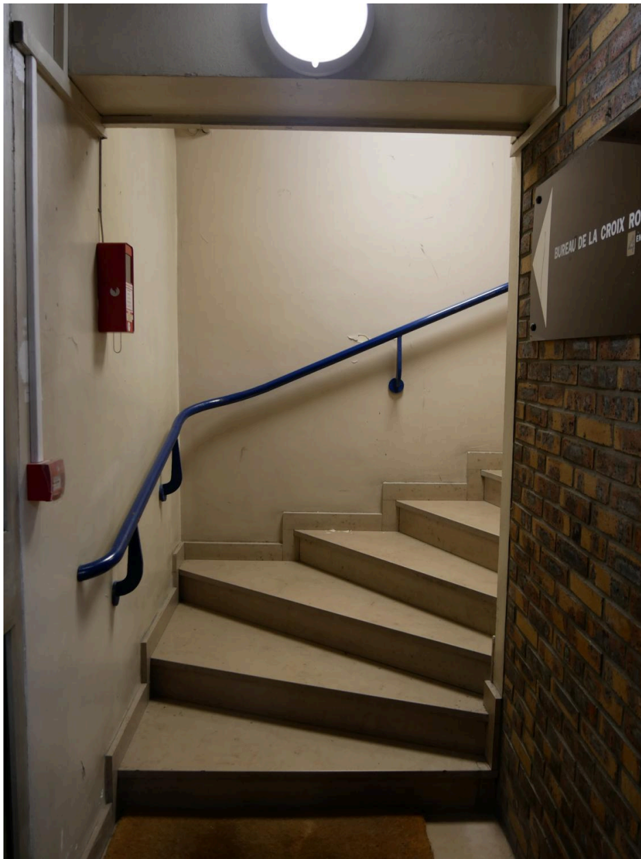
Escalier reliant le 1er étage
