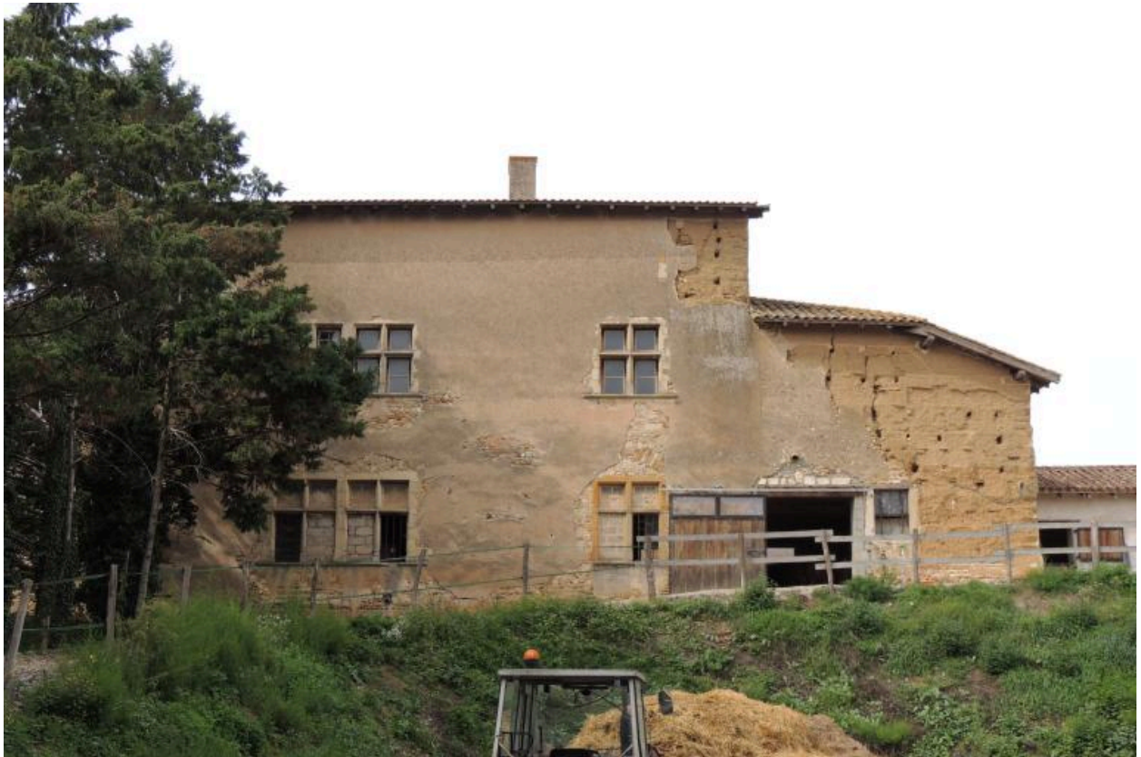
Le logis, façade sud.
