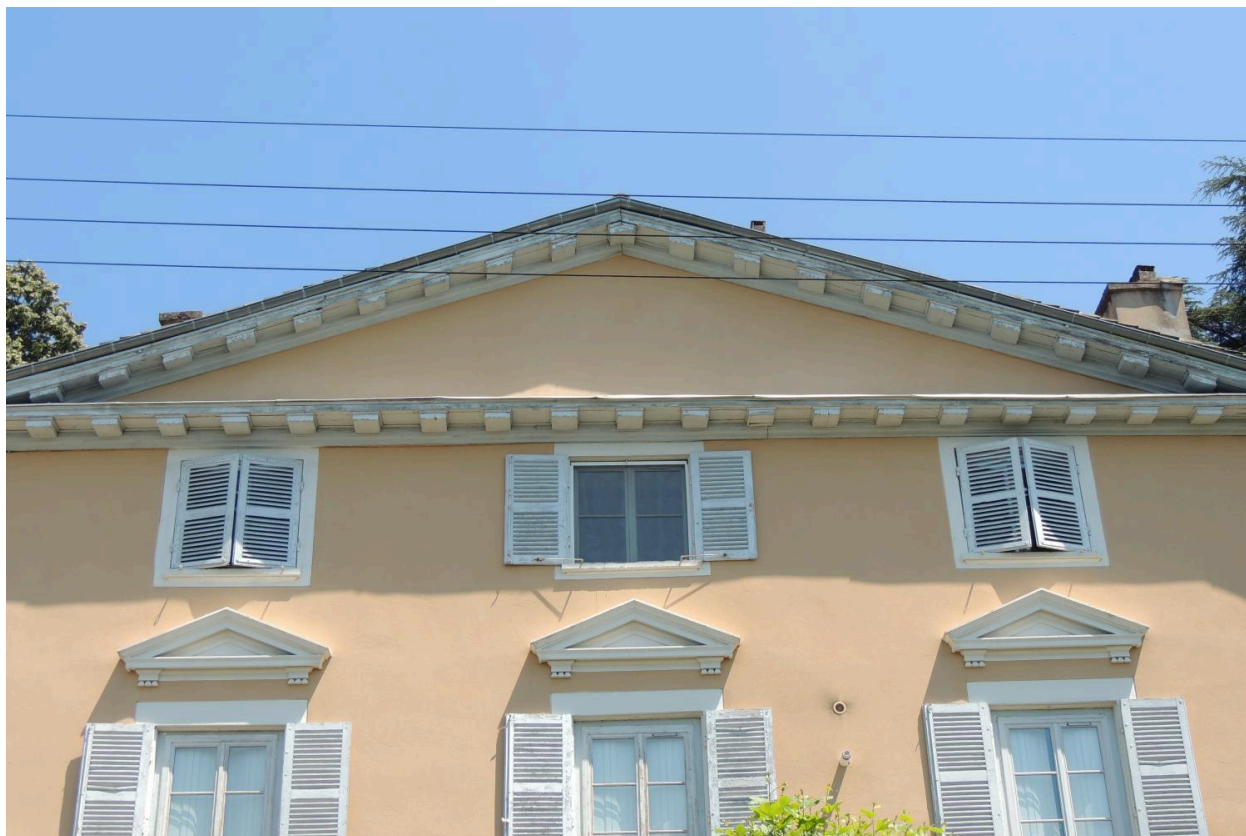
Façade : vue rapprochée du fronton.
