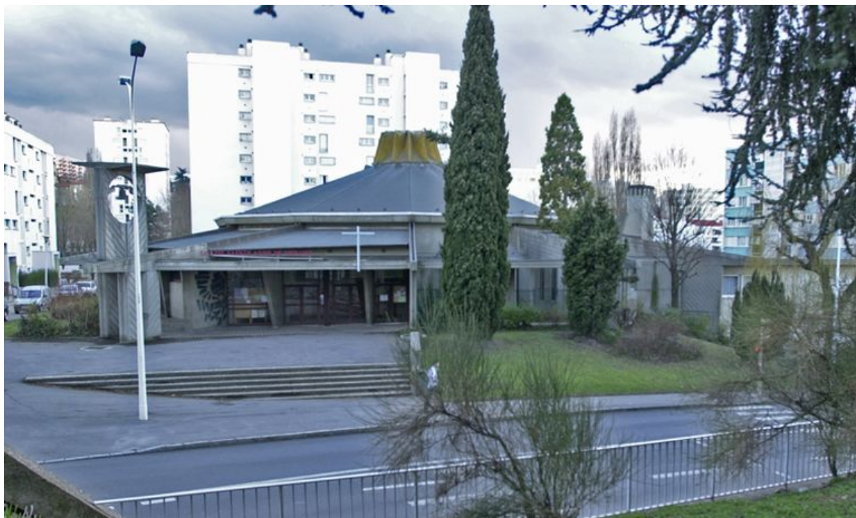
Vue générale depuis le nord
