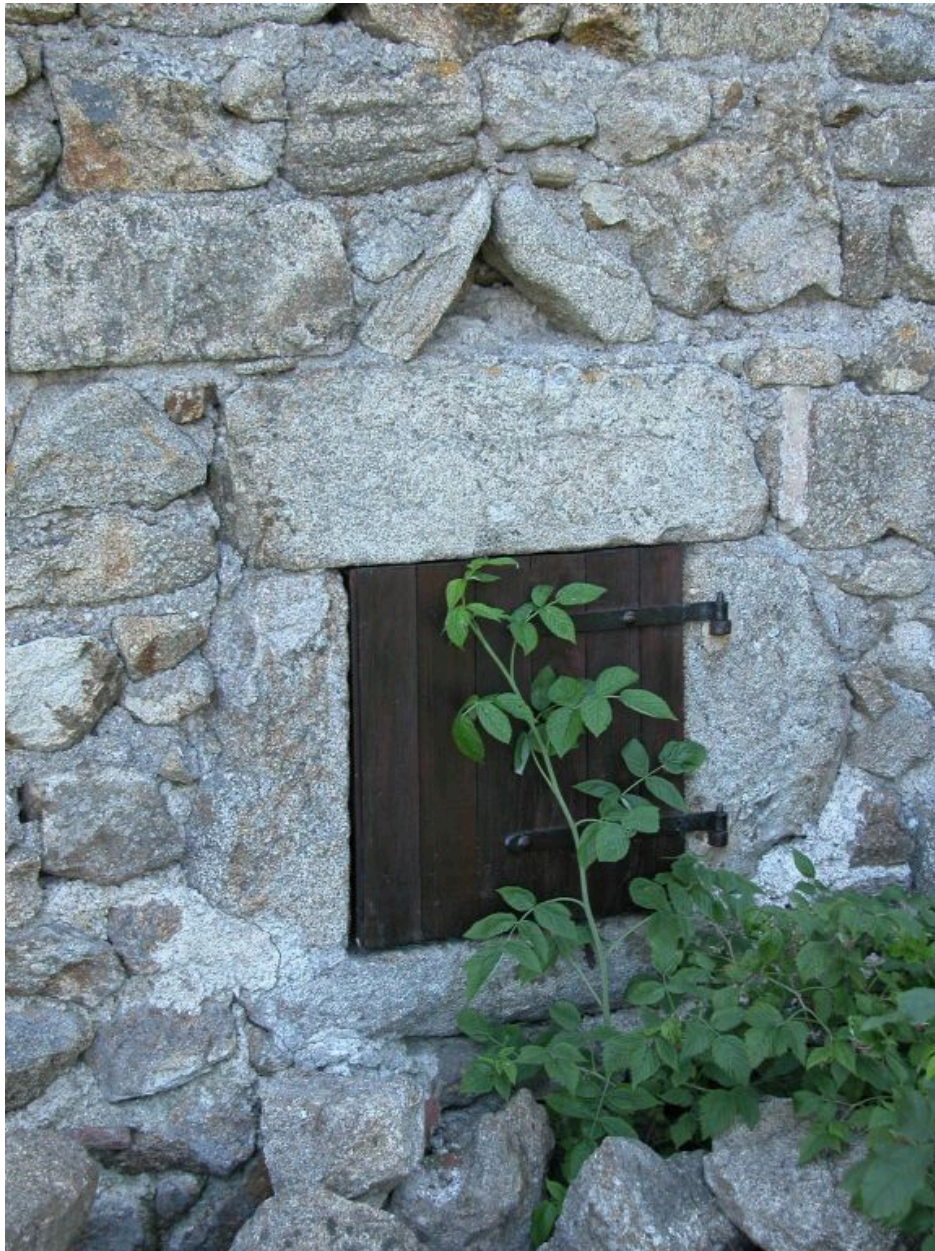
Mur gouttereau sud, détail de la baie éclairant l'étable.
