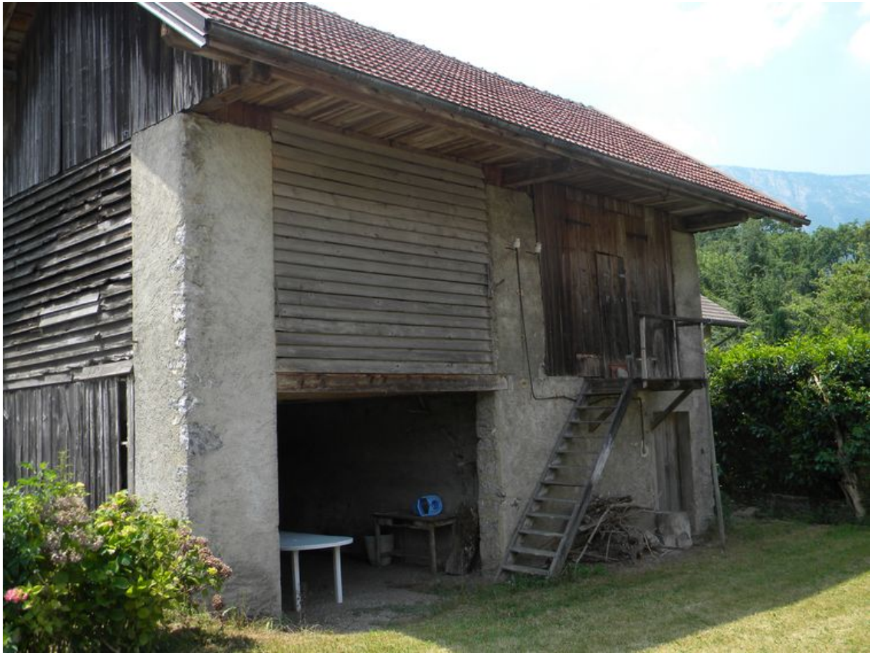
Vue de la façade principale de la grange.
