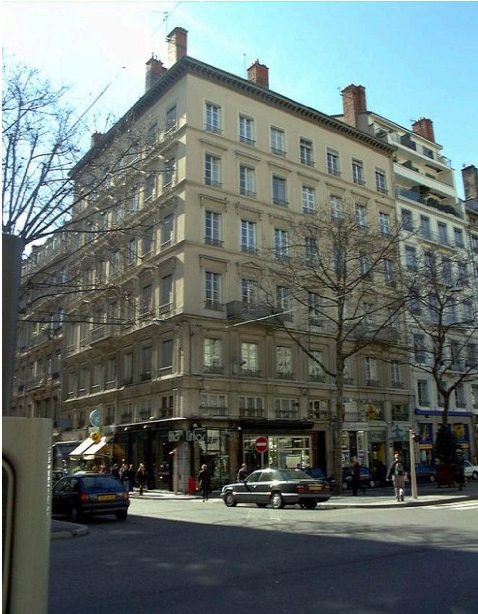
Vue générale des façades sur rue
