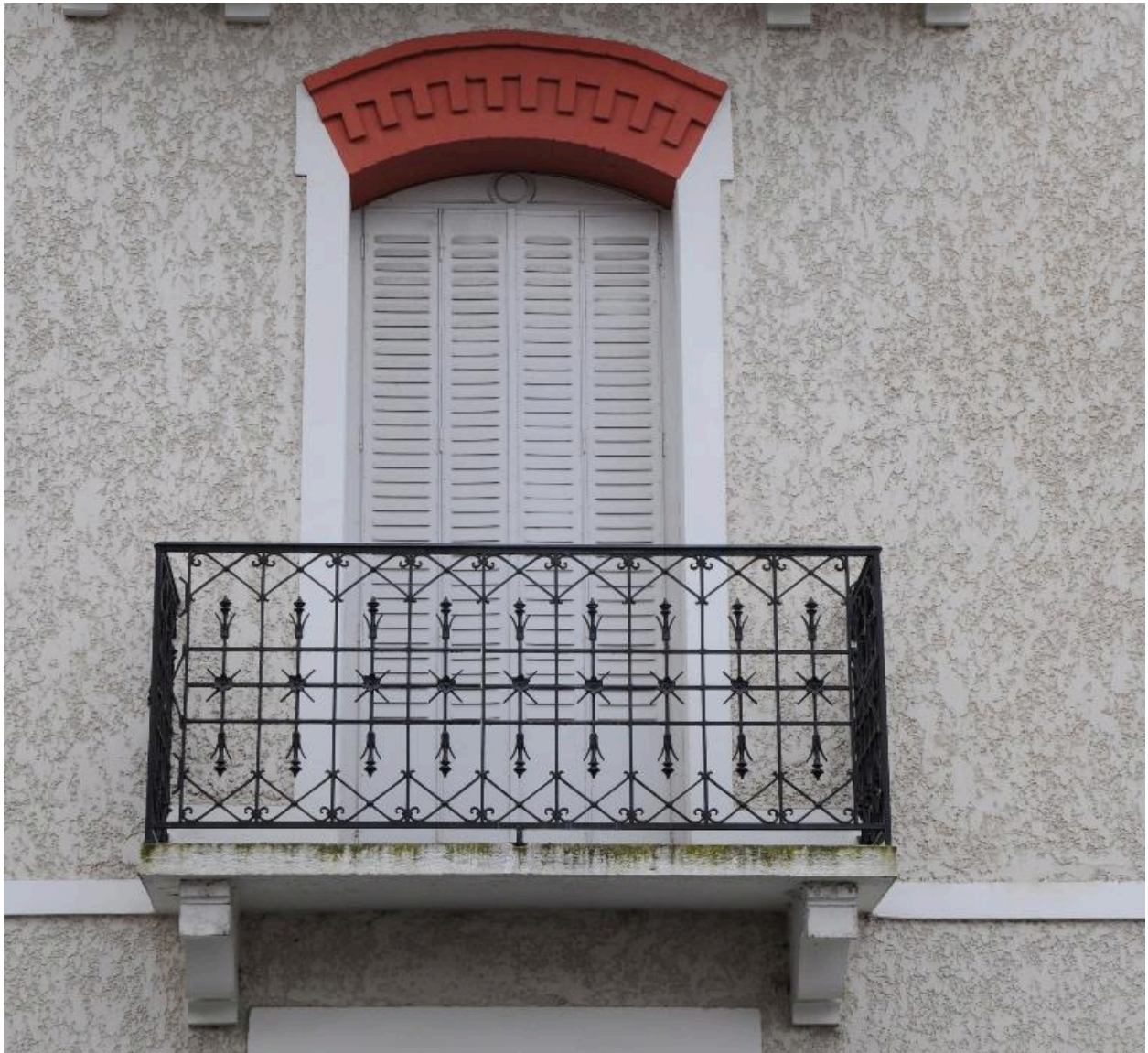
Baie du 1er étage
