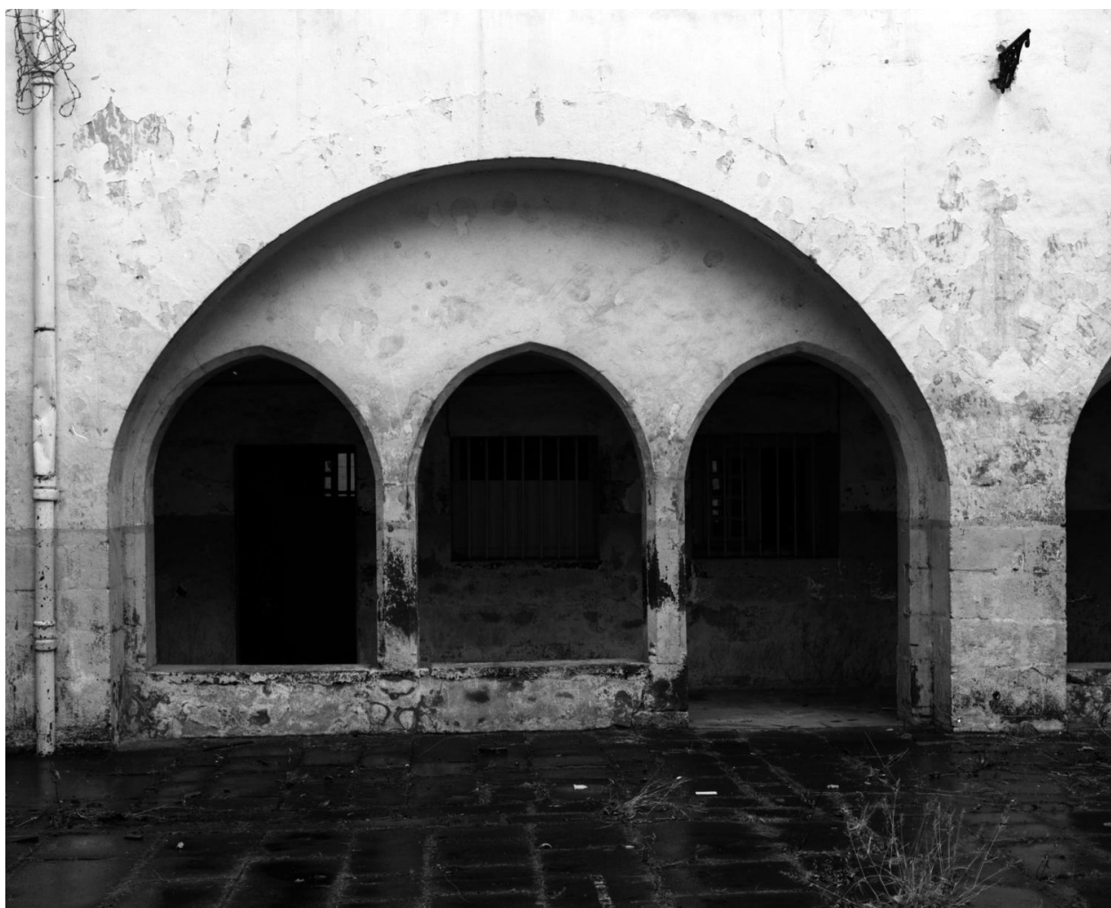
Cloître, groupement de trois baies libres dont deux sur bahut (2e groupement à partir du sud) dans la galerie ouest.
