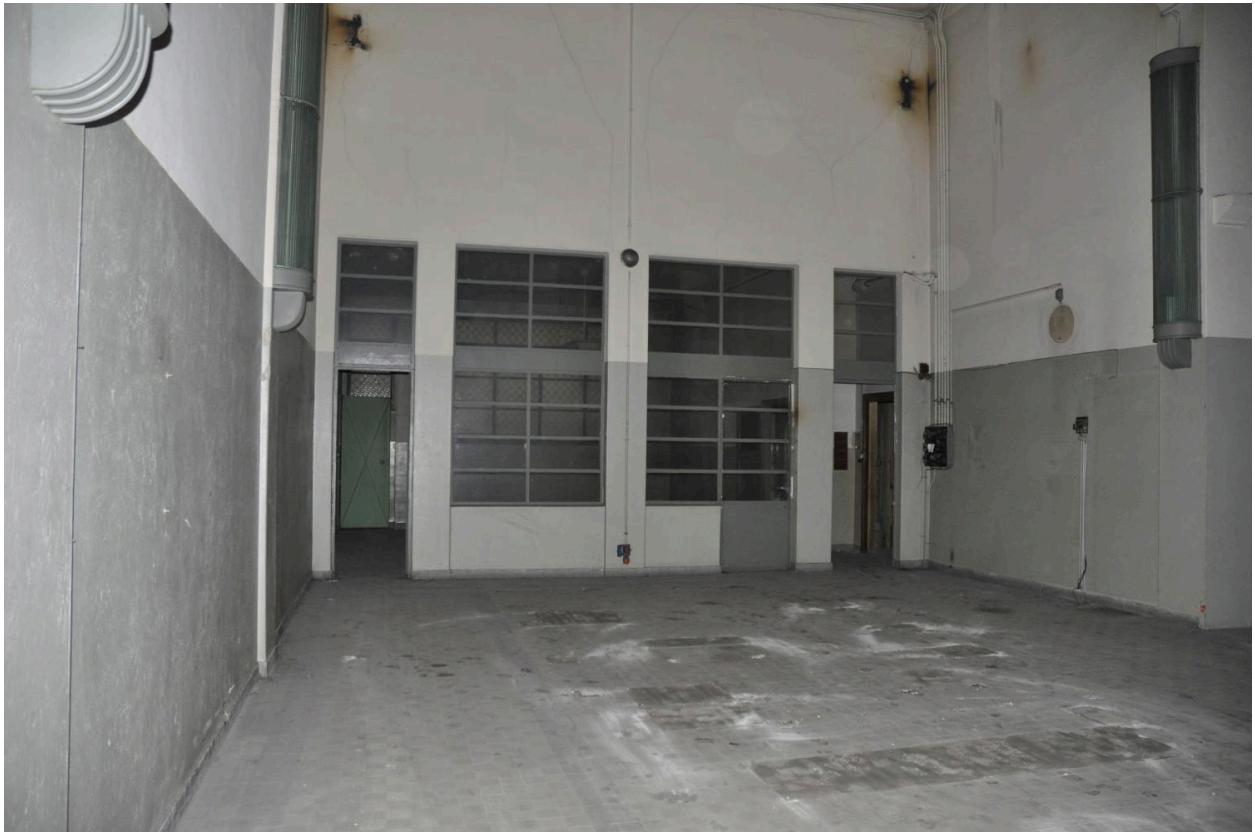
Salle des mutateurs rez-de-chaussée
