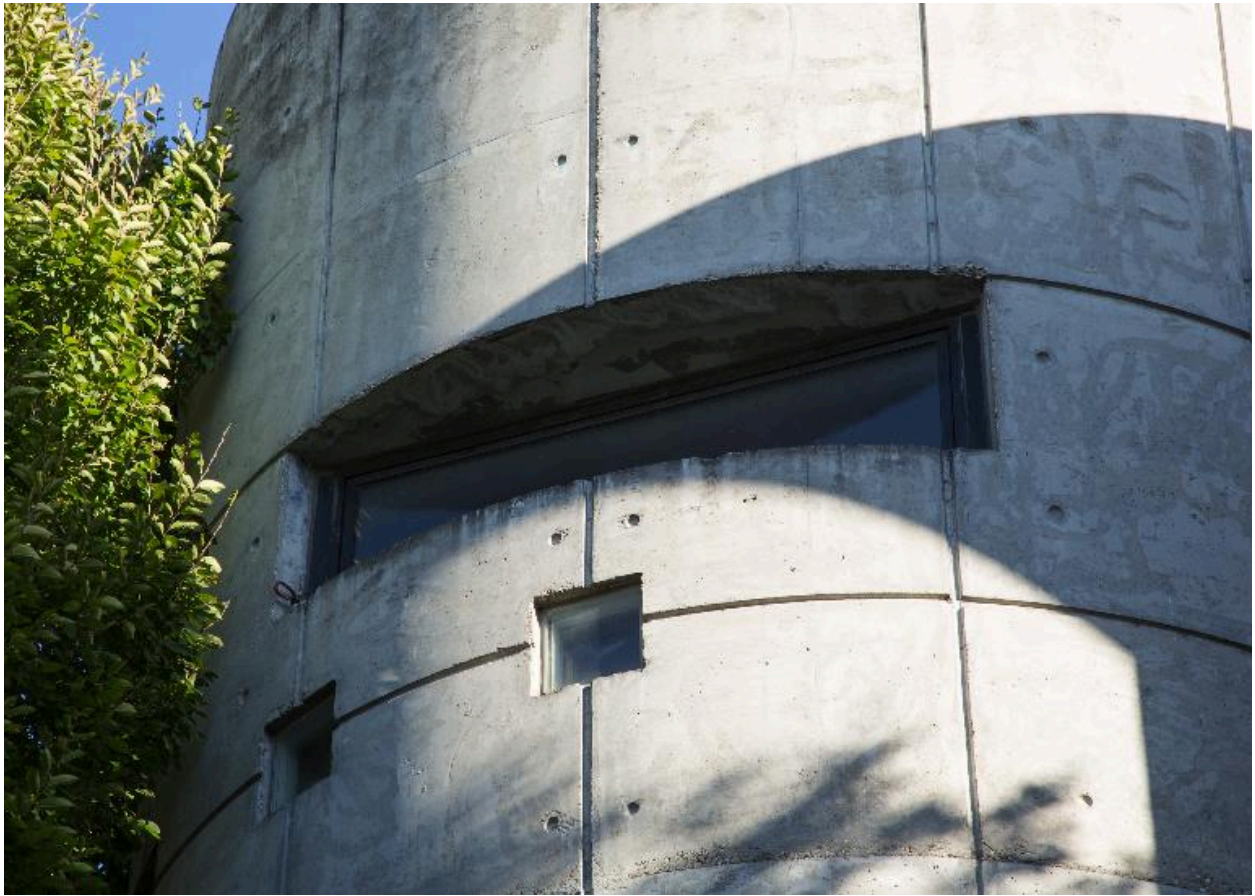
Bâtiment E. Détail
