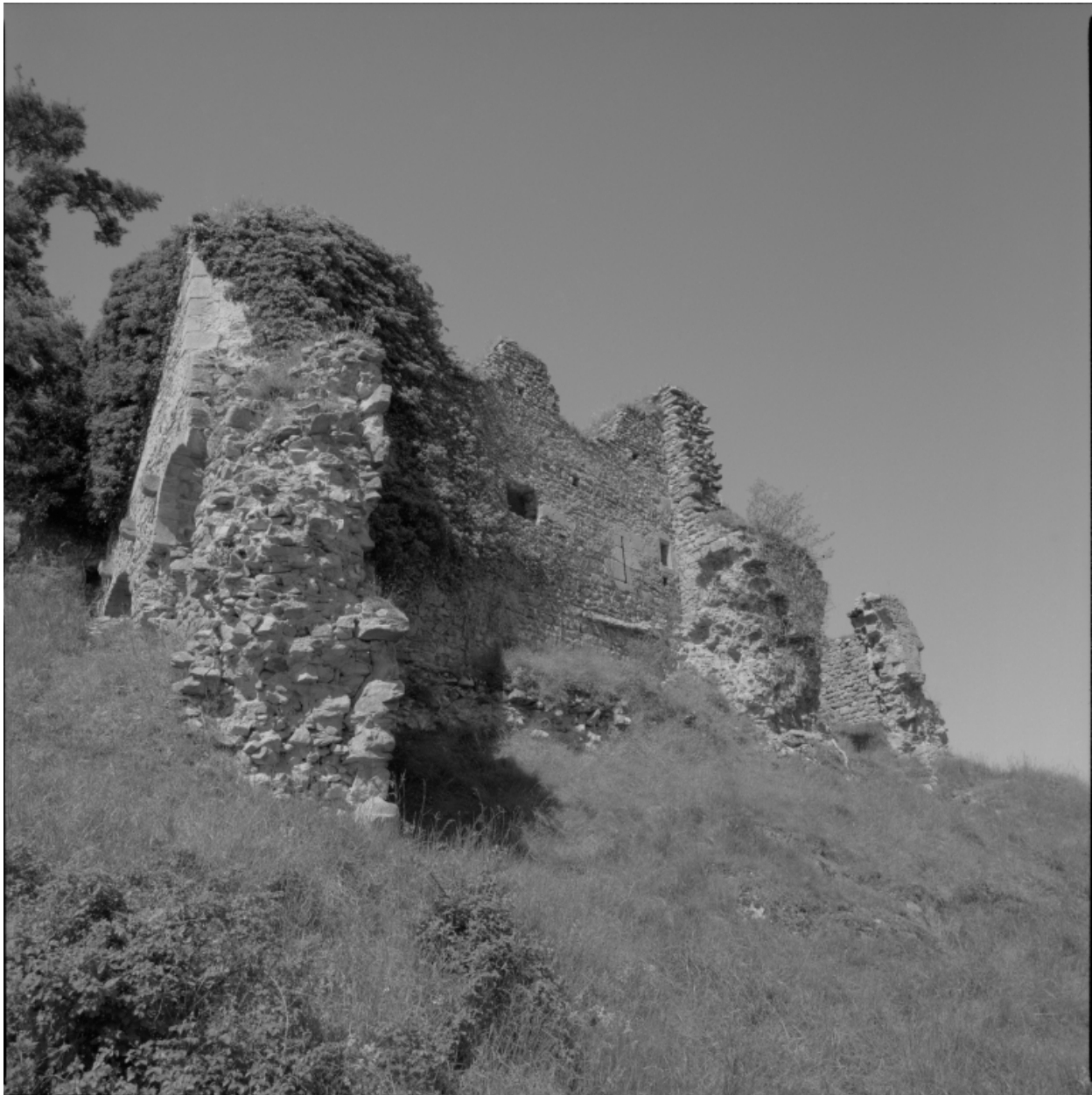
Premier baile, partie nord-est : vue des murs de la deuxième enceinte arrachés et d'une archère à étrier, de l'est.
