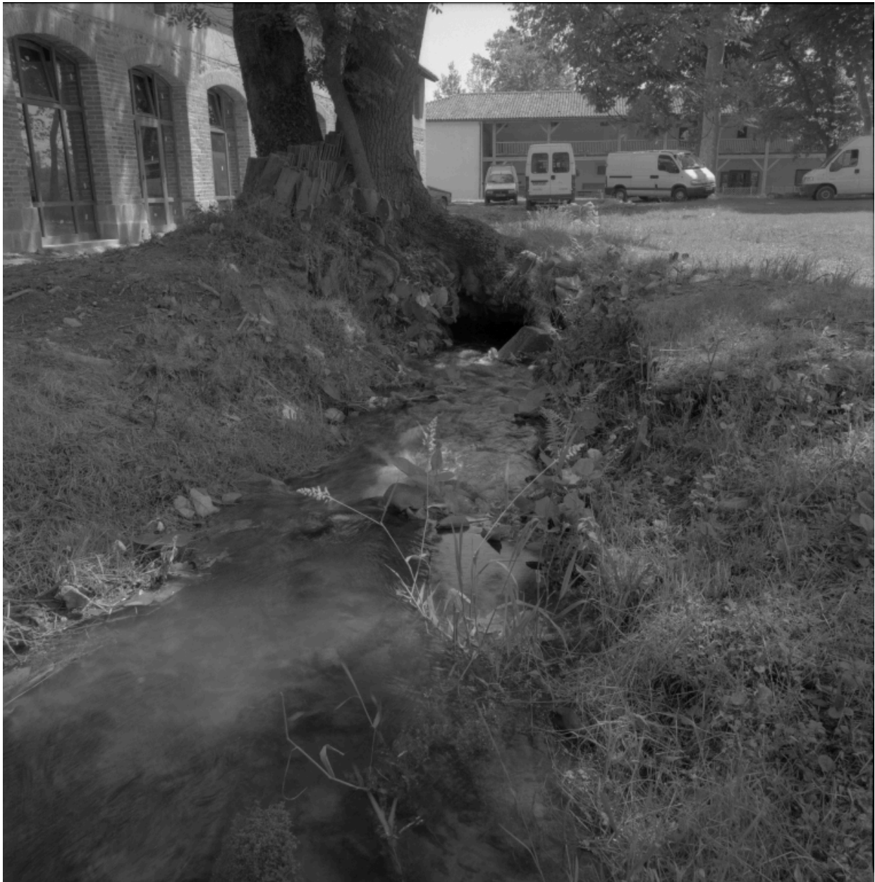
Détail du bief auprès du bâtiment ouest des communs, de l'ouest.
