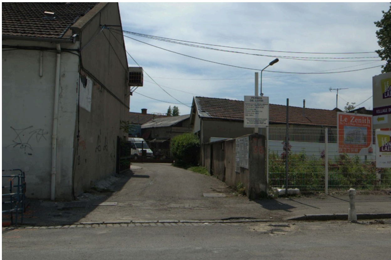
Entrée principale emmenant aux ateliers
