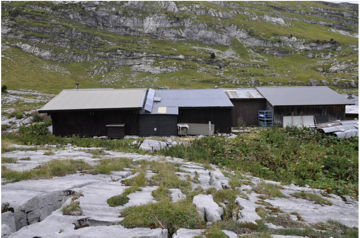
Vue d'ensemble des quatre chalets construits en bande
