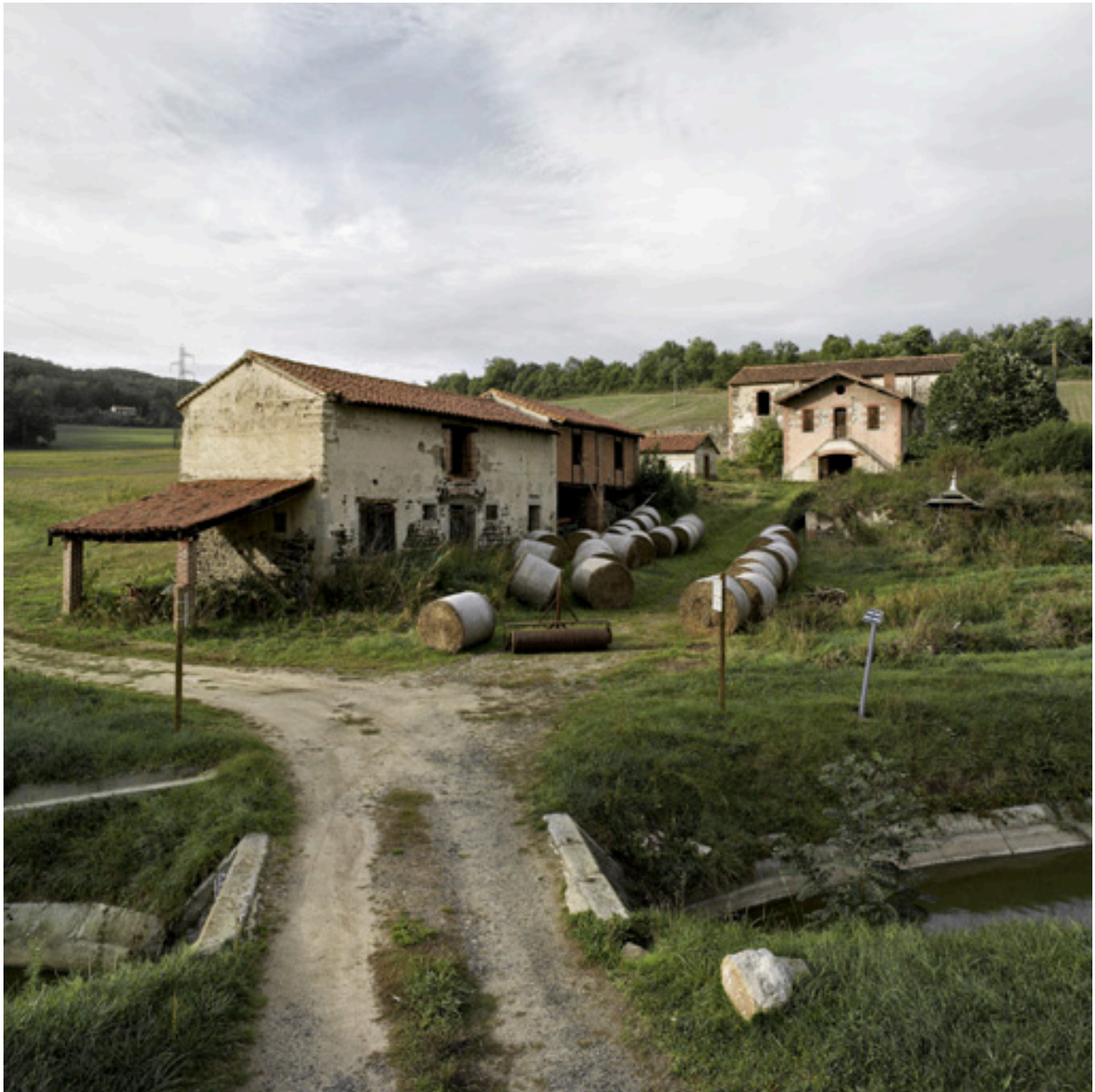
Vue générale depuis le sud-est. Au premier plan, croisement du chemin et du canal du Forez.
