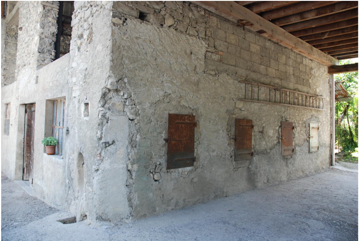
Dépendance (grange-étable, séchoir à trumeaux, remise) (ilot E, 2018 I1 1396) : ouvertures pour alimenter les crèches depuis la grange.
