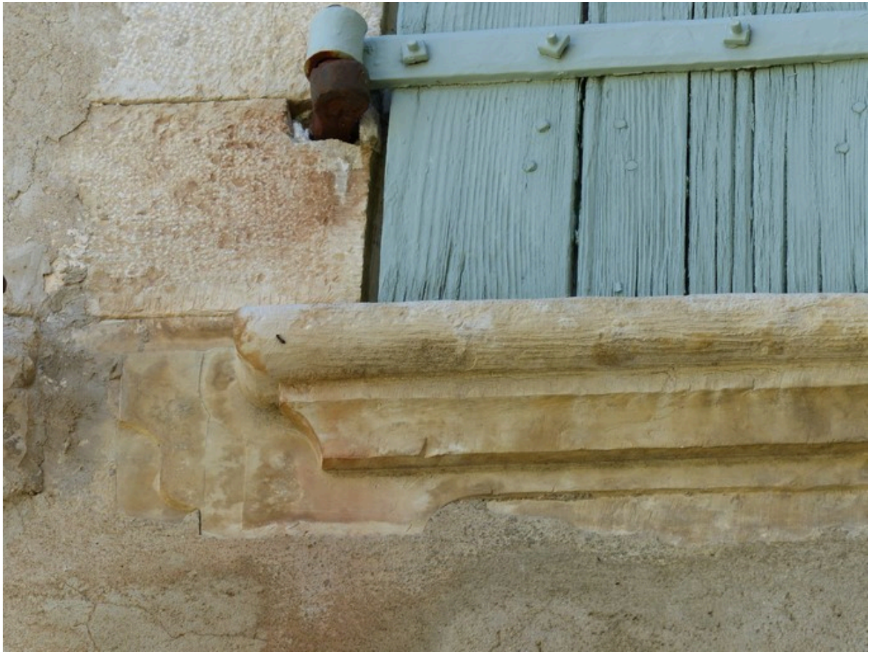
Bâtiment principal. Pignon sud, deuxième niveau. Fenêtre est, détail de l'appui mouluré.
