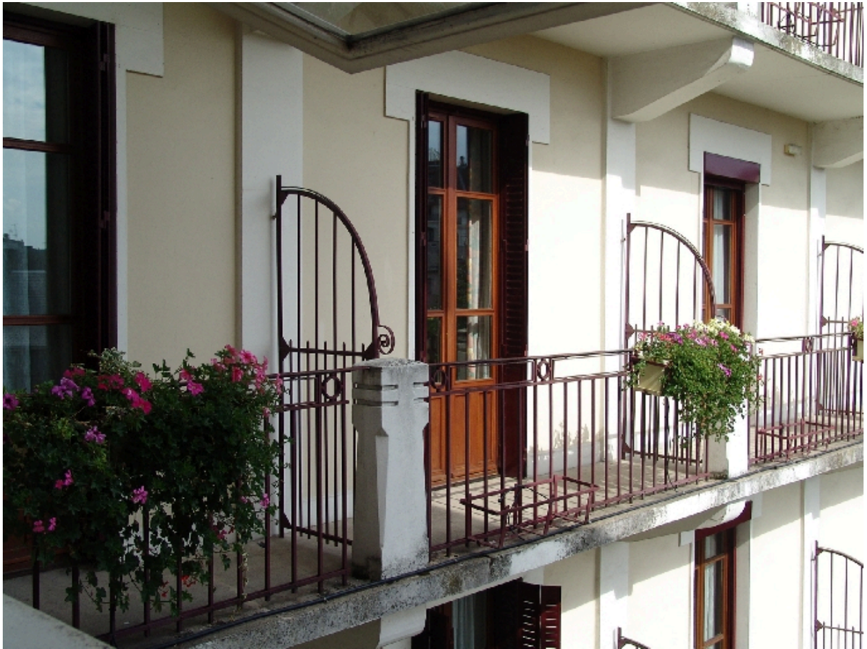
Détail des balcons
