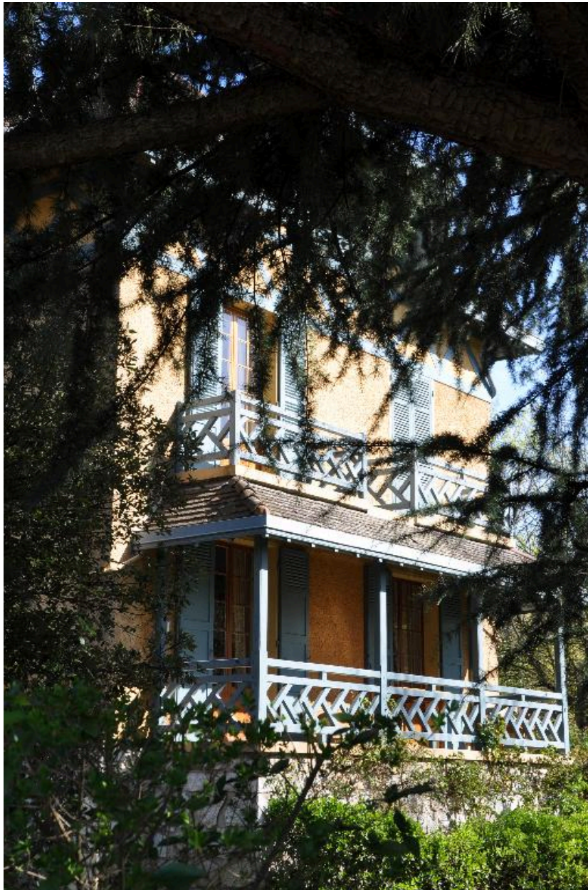
Façade principale orientée à l'ouest
