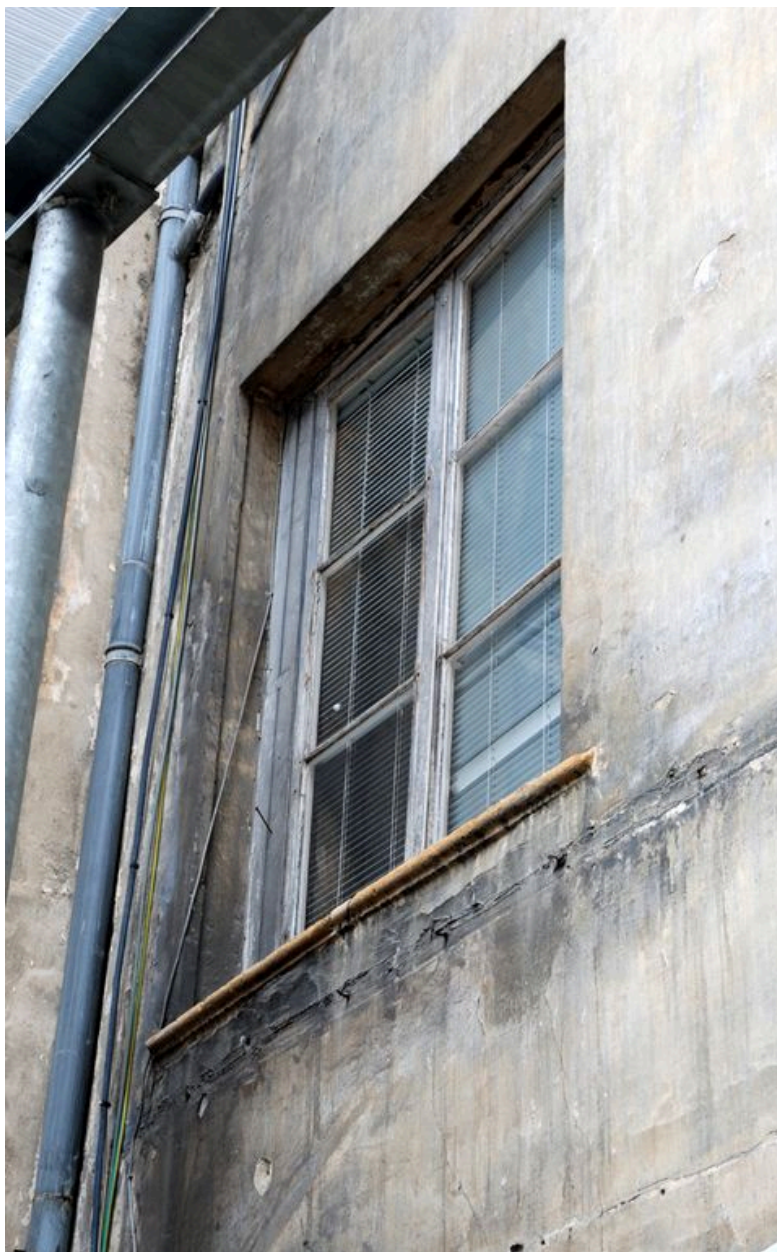
Elévation postérieure, détail d'une baie du 2eme étage
