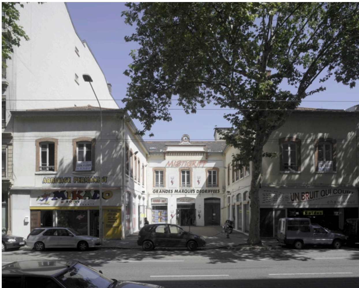
Vue générale sud
