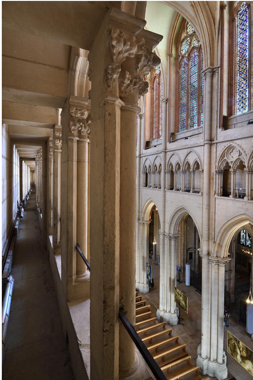
Nef et bas-côté sud depuis l'angle nord-ouest du triforium
