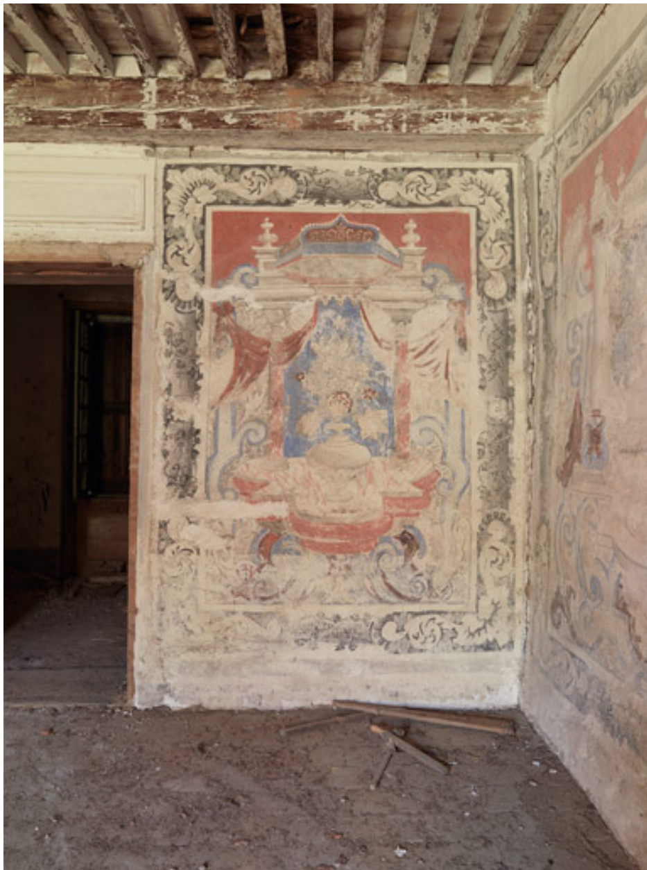
Mur est, vue du panneau droite de la porte d'entrée.
