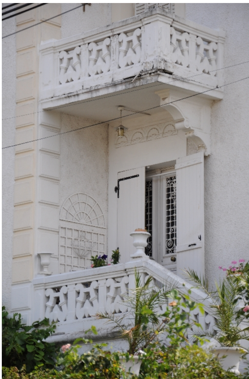
Détail, balcon sur la porte d'entrée
