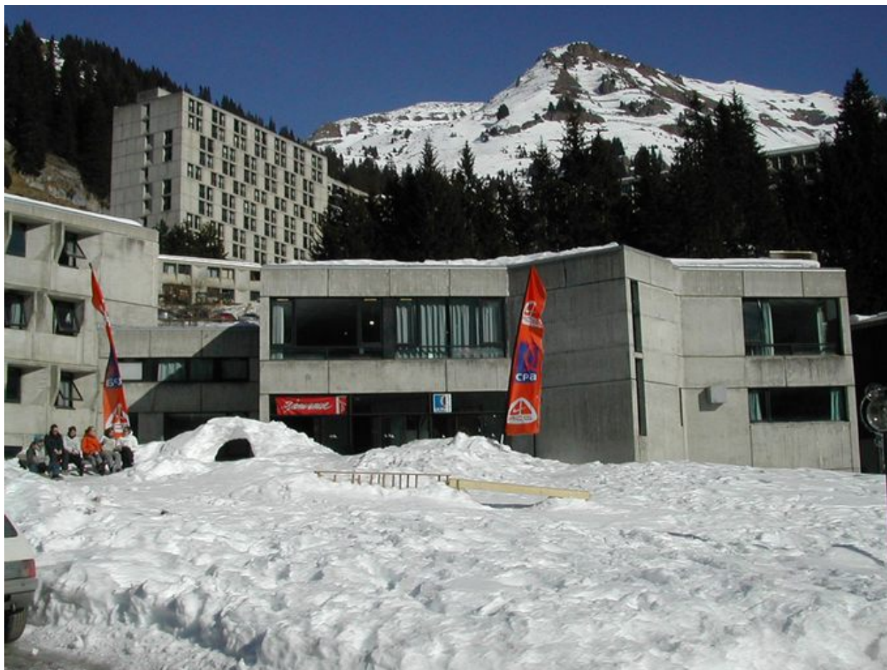
Le bâtiment d'entrée avant réfection. Vue depuis le sud-ouest
