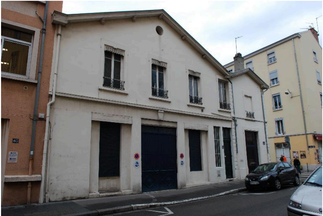
Vue sud ouest de la façade principale
