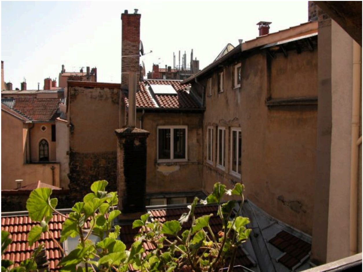
Corps arrière, élévation sur la 2e cour du 3 quai de la Pêcheurie
