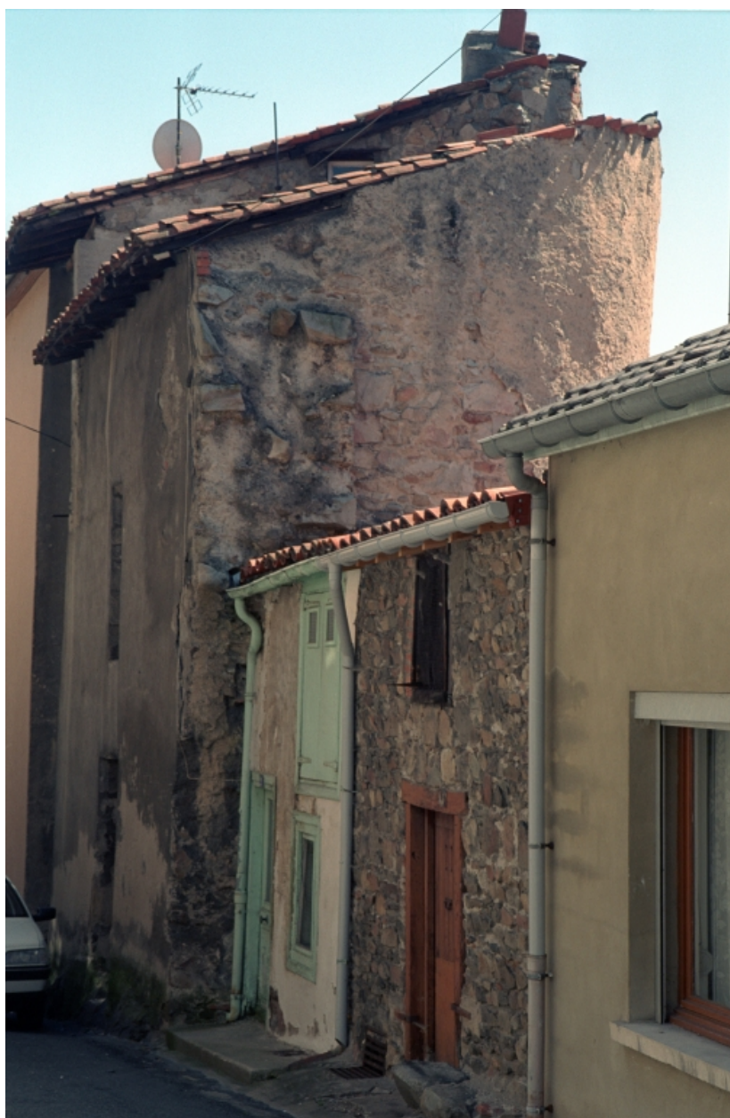
Boën, îlot 14, 11 Novembre (rue du) 19, 21 / Gustave Labrosse (rue) 16, 18. Vue générale des façades sur rue.
