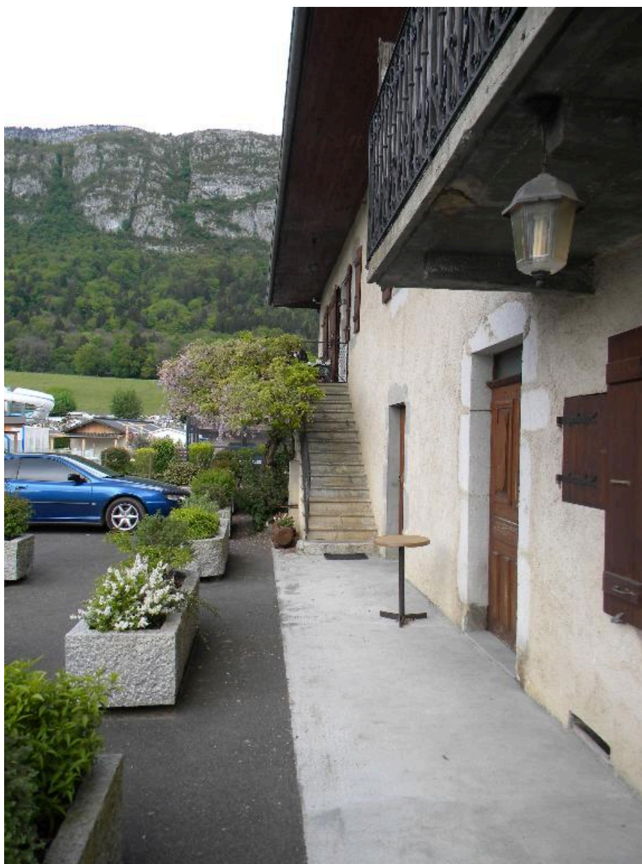
Vue de la montée descalier en façade sud.
