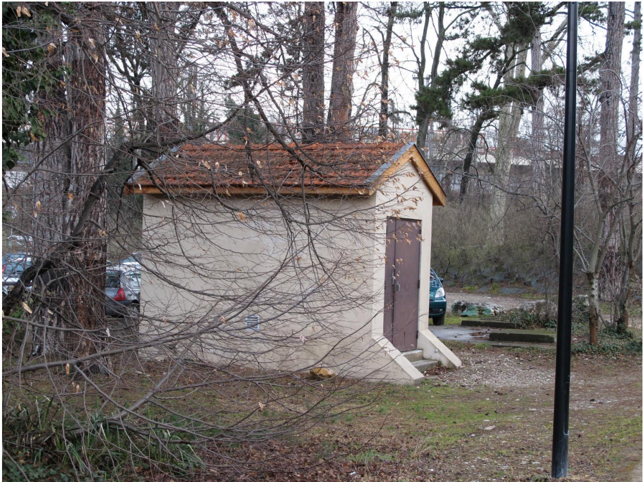
Entrée principale des bassins filtrants
