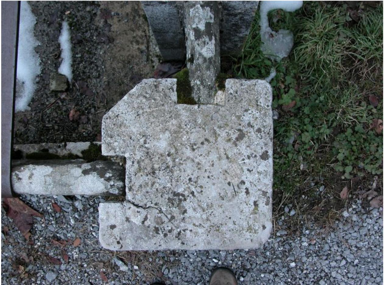
Détail de l'assemblage d'un piédroit
