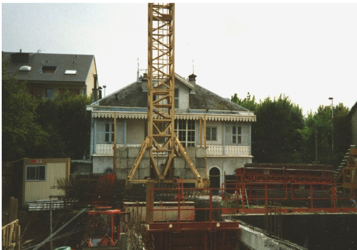
Façade postérieure, avant démolition
