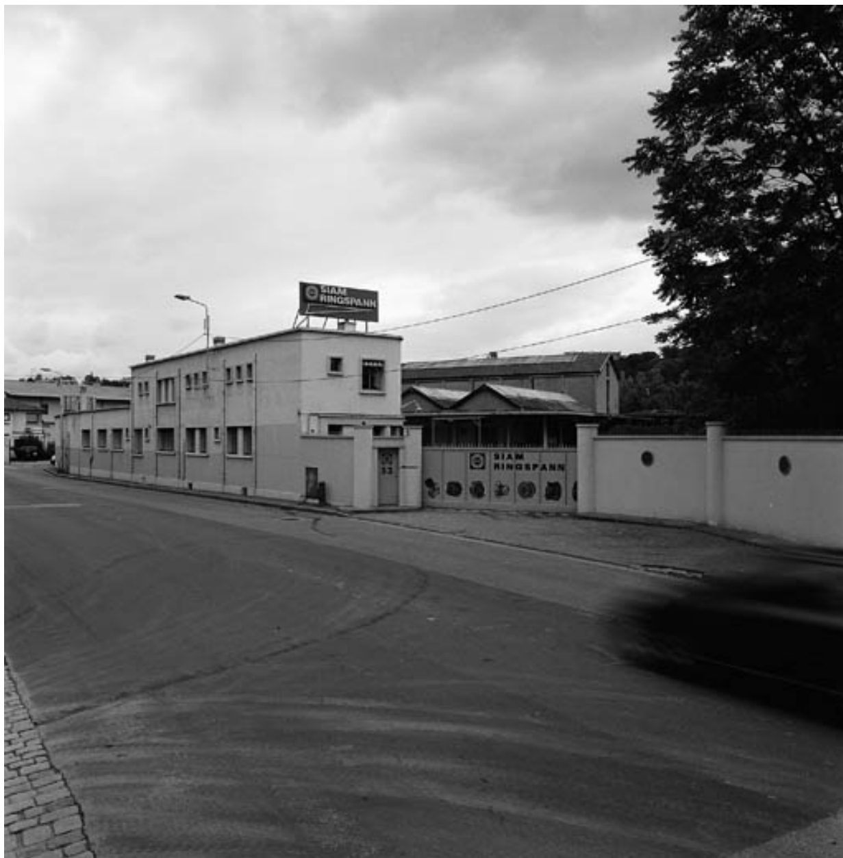
Vue d'ensemble sud-ouest
