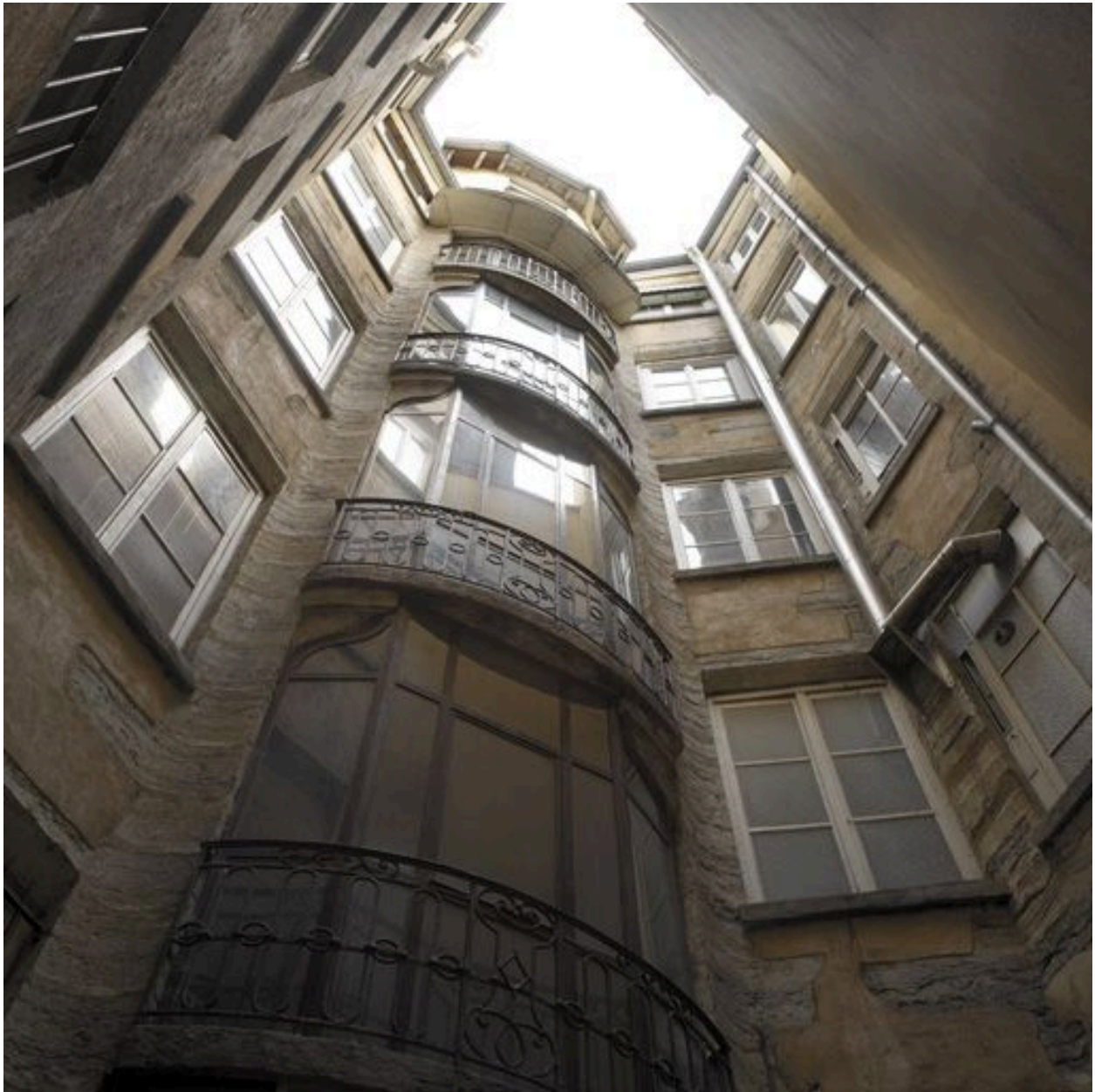
Vue générale par-dessous des élévations sur cour
