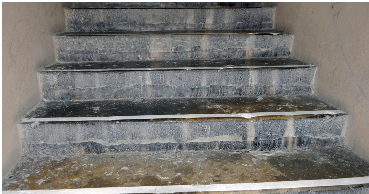
Escalier G : marques de tâcheron sur les contremarches
