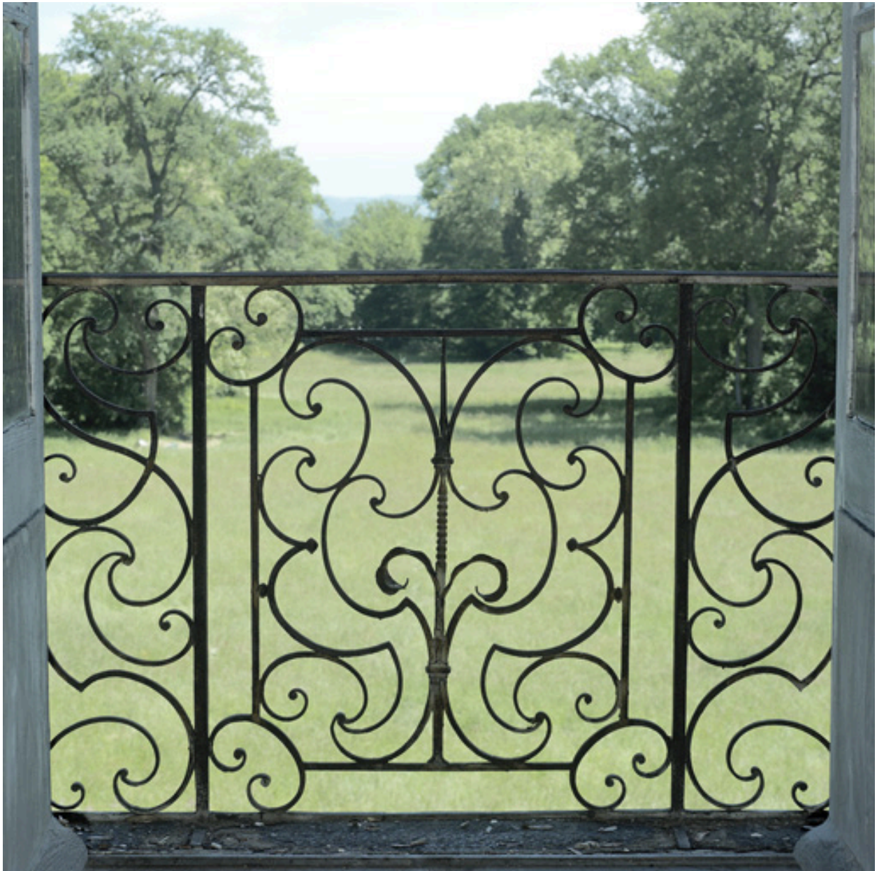
Vue du garde-corps de la fenêtre axiale du premier étage, côté parc.
