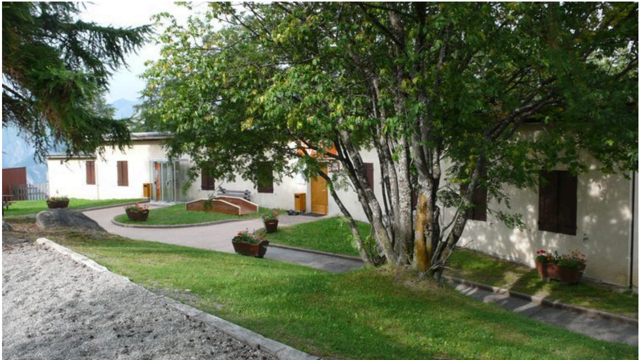
Vue depuis le sud-est
