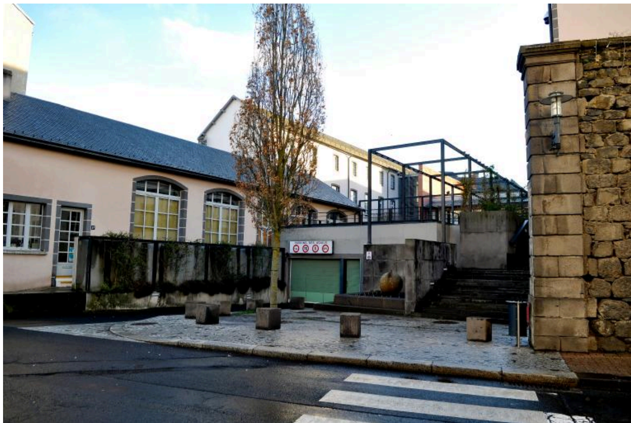
Ancienne entrée du collège, réaménagée lors de la création du parking des Agials
