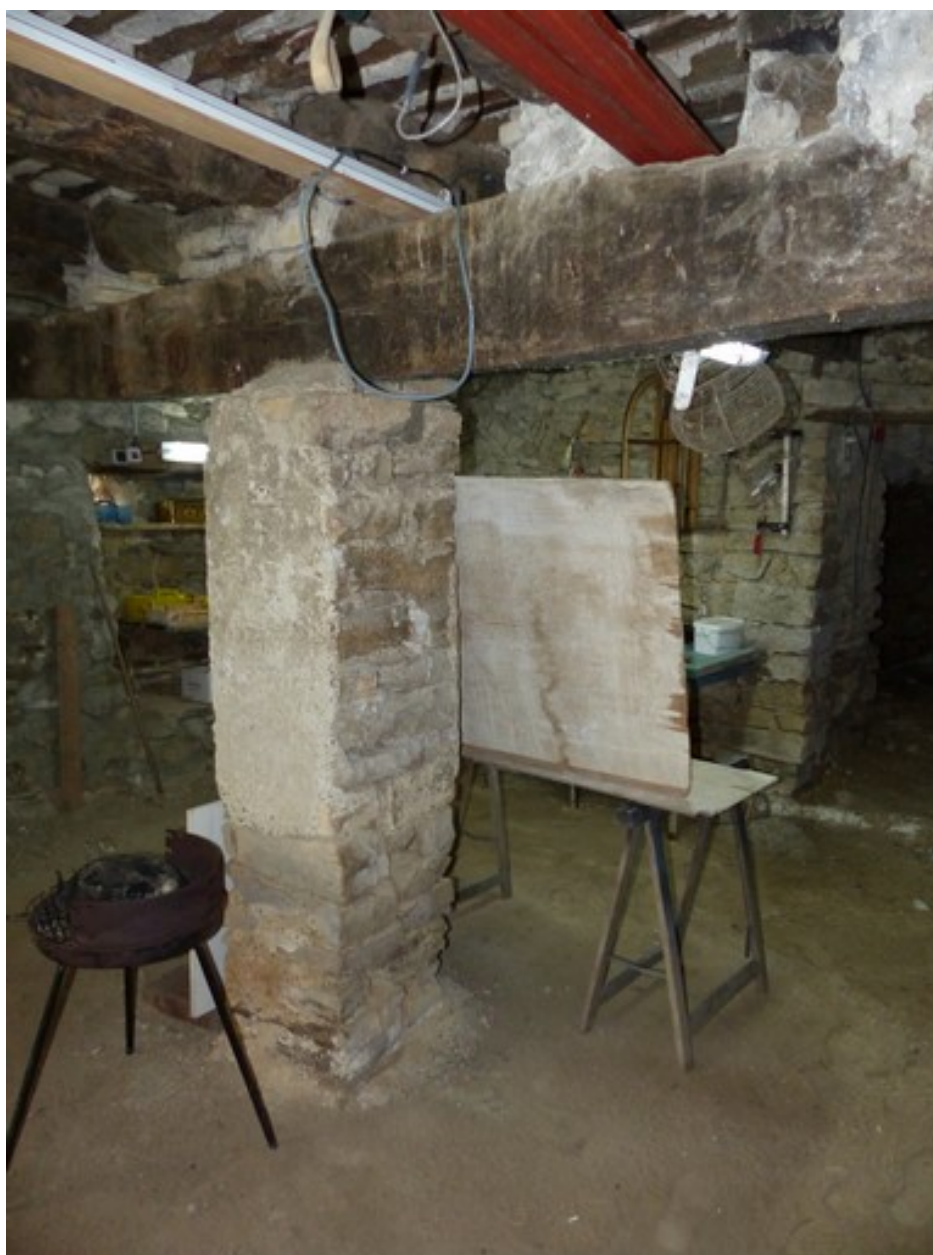
Etage de soubassement, étable. Pilier maçonné et poutre.
