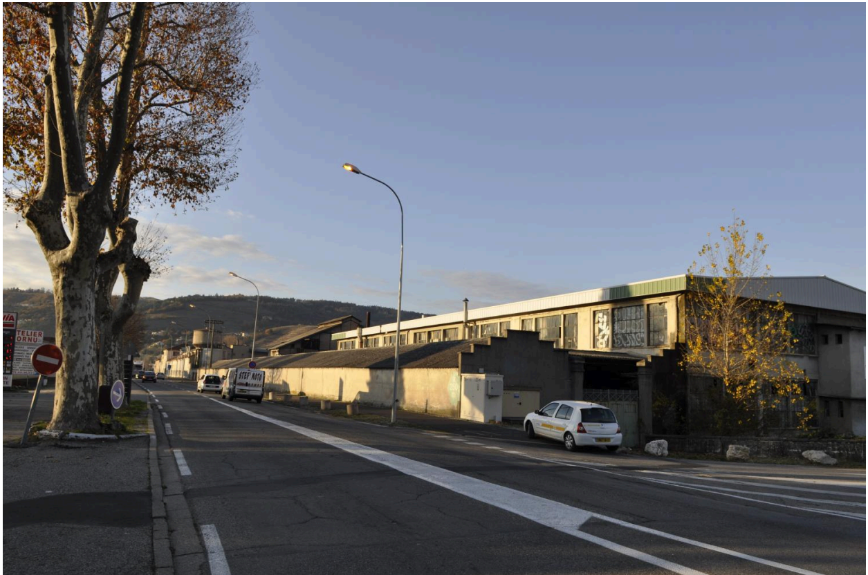
Vue Sud du site le long de la route de Lyon
