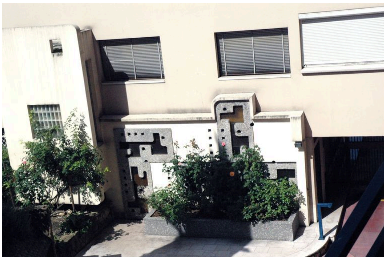
Détail du rez-de-chaussée de l'élévation postérieure
