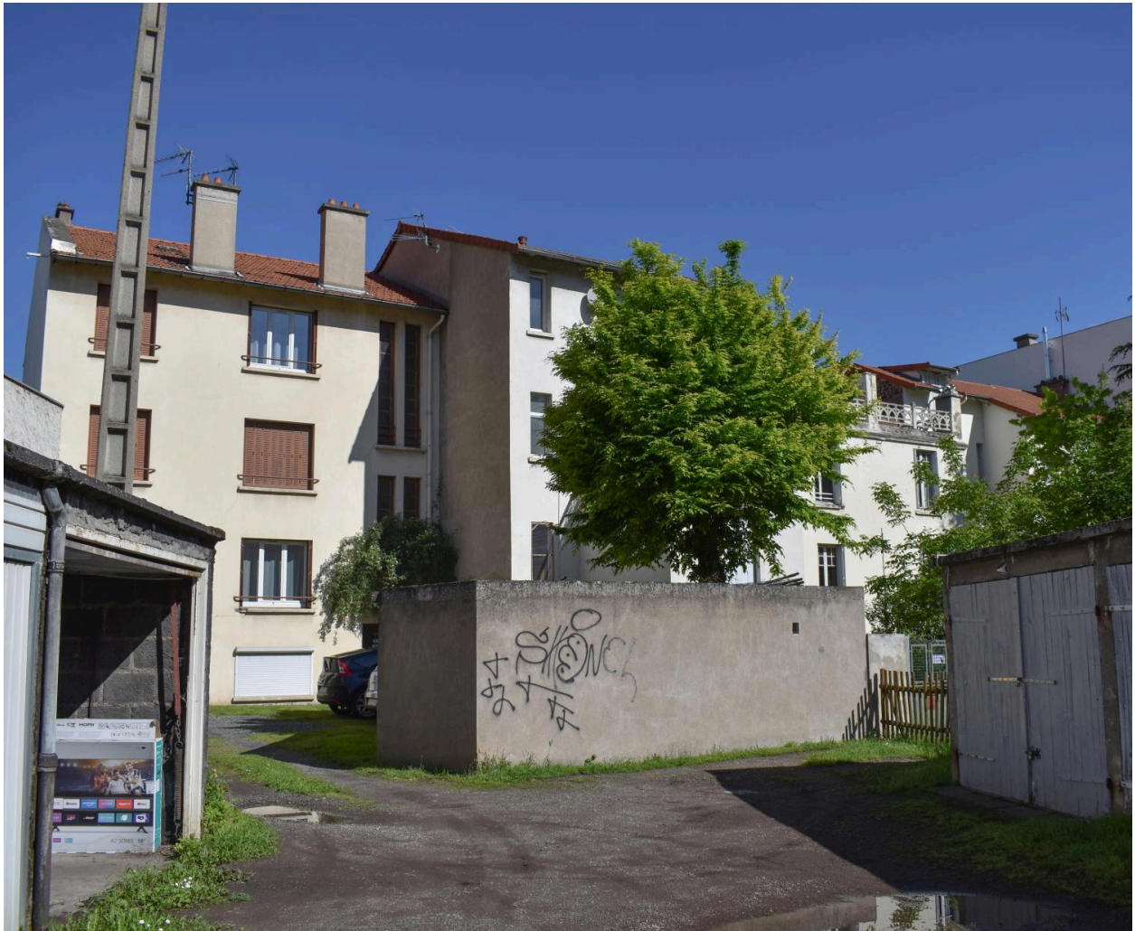
Elévations postérieures sur la cour
