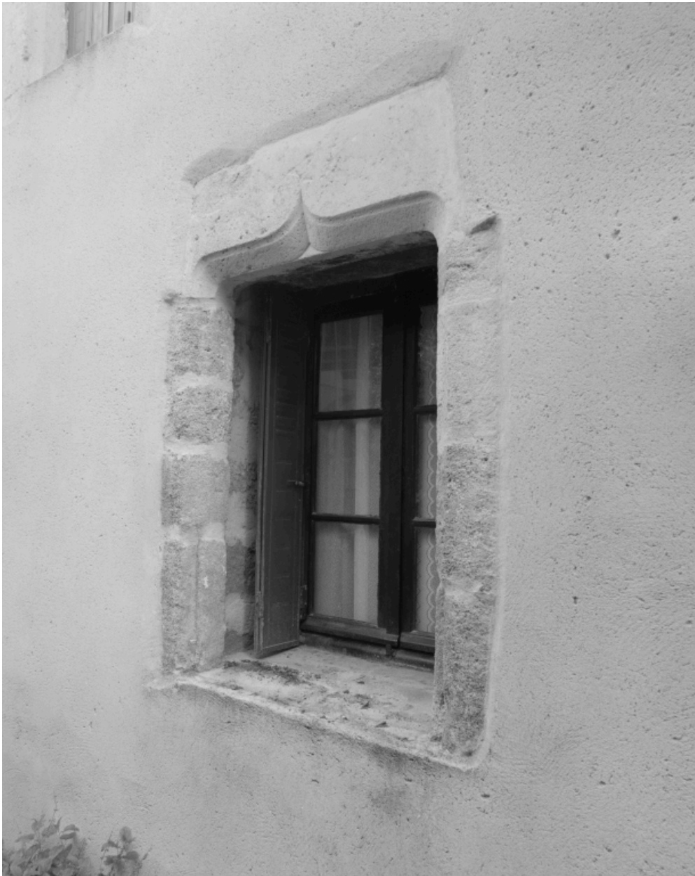
Détail d'une fenêtre en accolade d'une maison située dans le village.
