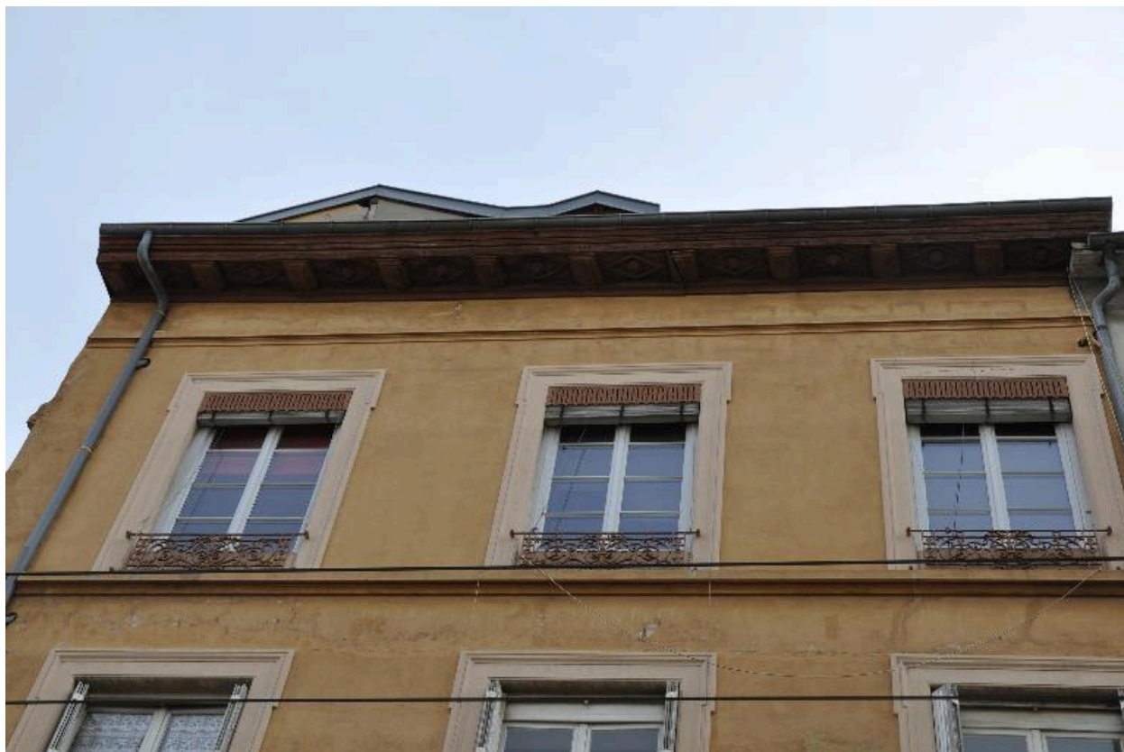
Détail de la corniche côté nord
