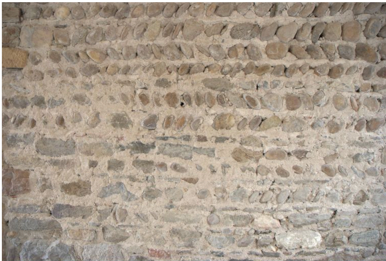
Détail du parement, mur nord du passage d'entrée
