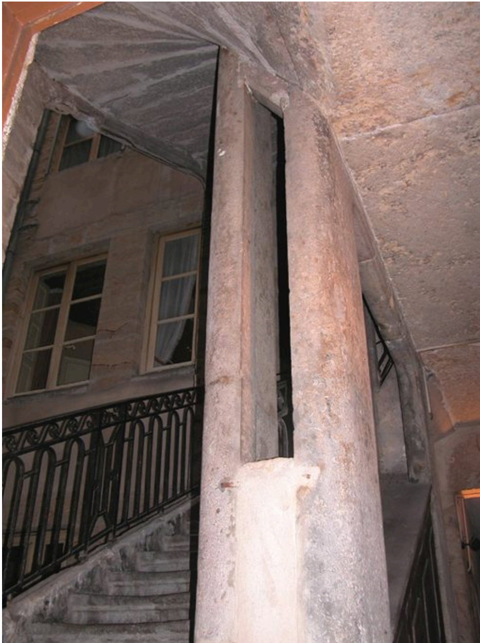
Vue partielle de l'escalier à quatre noyaux
