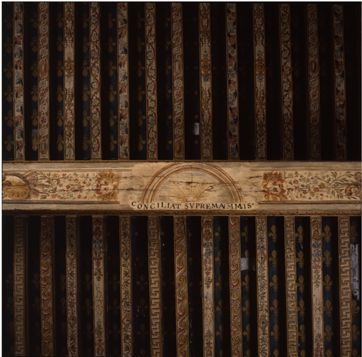
Poutre 4, face inférieure, centre : arc-en-ciel et soleil couchant, avec la devise CONCILIAT SUPREMA IMIS (il unit les sommets aux profondeurs).
