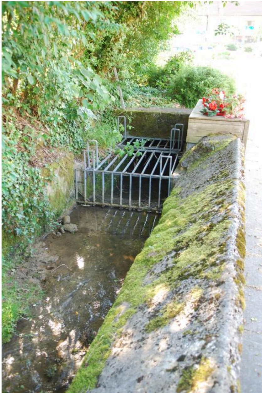
La Pallud, lavoir dans la rivière des Massettes, vue d'ensemble vers le nord
